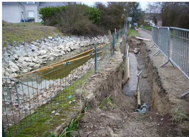
Des travaux en urgence ont été menés pour soutenir un mur qui s'effondrait à la mare des Baluères.
