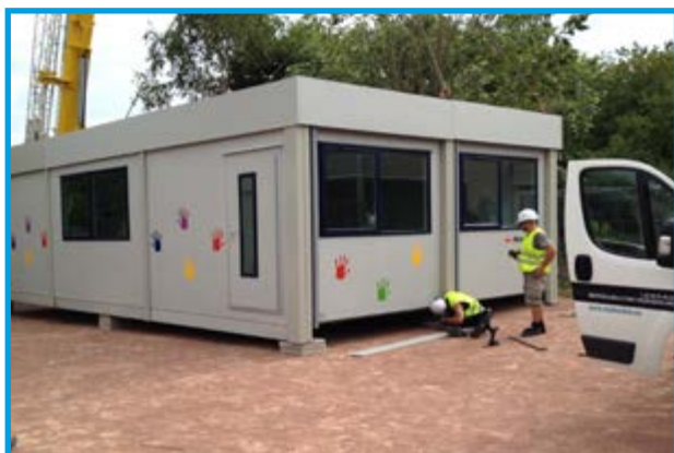
Les modulaires pendant les travaux.
