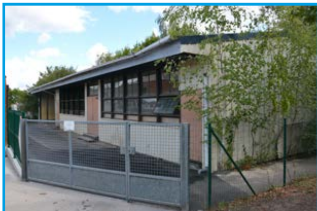
Les préfabriqués avant les travaux.
