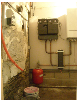
La chaufferie en cours d'installation
